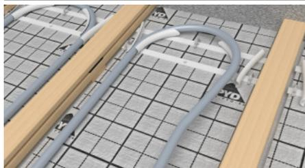
Nach dem die PYD®-Montagebögen verlegt und fixiert wurden, wird das PYD®-Systemrohr verlegt. Dazu wird es über den Bogen gezogen und eingehängt.
