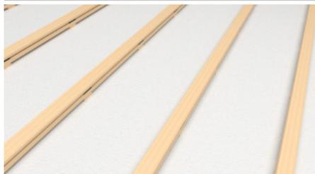
Die Schwingbodenkonstruktion, sowie die bauseitige Wärmedämmung sind wie geplant verlegt.
