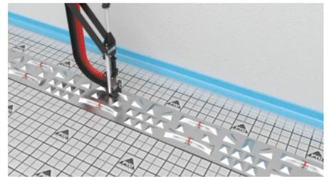
... durch das PYD®-Systemclipperwerkzeug auf der faltplatte fixiert.
