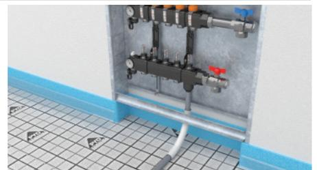
Der PYD®-AD20 Adapter wird am Gewinde des Vorlaufs angesetzt und die Überwurfmutter mit einem Ringmaulschlüssel NW30 vorsichtig angezogen.
