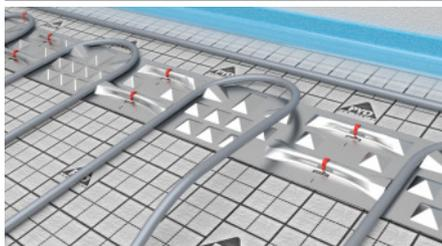
Das Abrollen erfolgt von Hand oder mit Hilfe der PYD®-Rohrverlegehaspel. Das PYD®-Systemrohr wird wie oben abgebildet über den PYD®-Umlenkbogen geführt.
