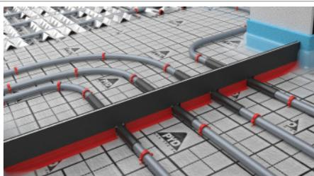
Das PYD®-DF10 Dehnfugenprofil wird an der geplanten Stelle angesetzt und Rohrkreuzungen markiert. Die Kreuzungspunkte werden ausgeschnitten und das Profil mittels Klebestreifen gesetzt.
