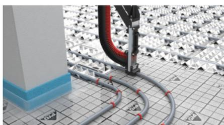
Als Abschluss werden alle lose befindlichen Rohrleitungen mit dem PYD®-Systemclipwerkzeug an der PYD®-Faltplatte befestigt. Das PYD®-Systemrohr wird alle 0,50 m befestigt.
