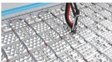
Beim PYD®-Umlenkbogen werden beide Leitungen sowie der Bogen mit einem PYD®-Systemclip fixiert. Bei Zementestrich muss nach jedem zweiten Blech getackert werden.
