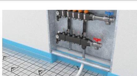
Der PYD®-AD20 Adapter wird am Gewinde des Vorlaufs angesetzt und die Überwurfmutter mit einem Ringmausschlüssel NW30 vorsichtig angezogen.
